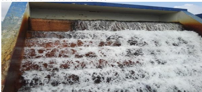
Figura 3. Equipo de aireación en la planta “La Guapucha” en la empresa EAF SAS ESP para un caudal de entrada de 280 L/s.
