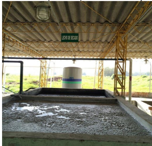
Ilustración 7 Tanque de acopio de vertimientos y lodos
