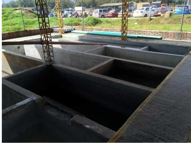
Ilustración 7 Tanque de acopio de vertimientos y lodos
