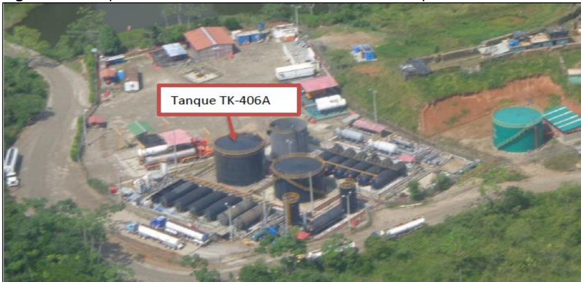
Figura 11. Tanque de Almacenamiento TK-406 A desde vista panorámica Estación C.
