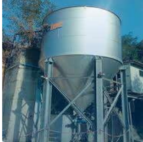
Figura 20. Decantador
