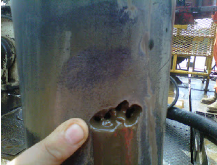
Imagen 4. Corrosión de tubería
