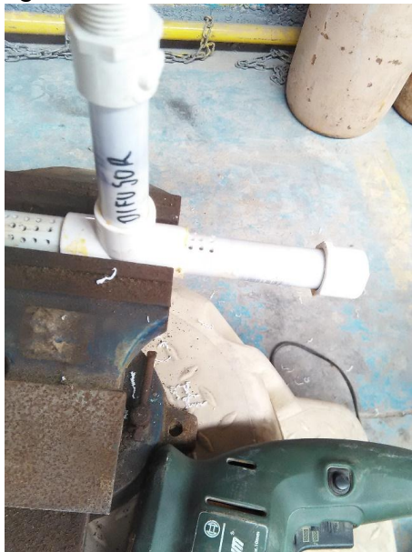
Figura 6: Construcción del difusor
