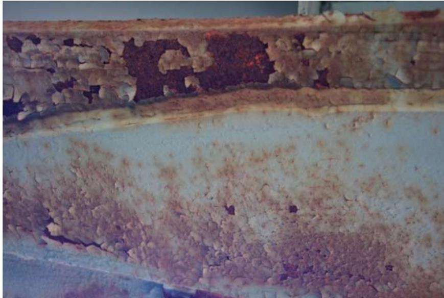
*Nota:* Se muestra la afectada por corrosión en una viga de soporte. Tomado de: Ameli, Z.; Nesheli, SJ; Landis, EN Clasificación de condición y segmentación de corrosión de puentes de acero basada en aprendizaje profundo mediante máscara RCNN y YOLOv8. *Infraestructuras* 2024, 9, 3.
