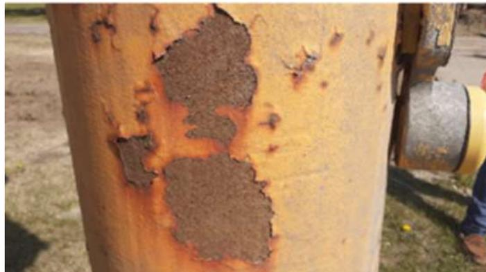
*Nota:* Muestra una corrosión uniforme sobre una tubería. Tomada de: Das, A.; Ichi, E.; Dorafshan, S. Image-Based Corrosion Detection in Ancillary Structures. Infrastructures 2023, 8, 66.
