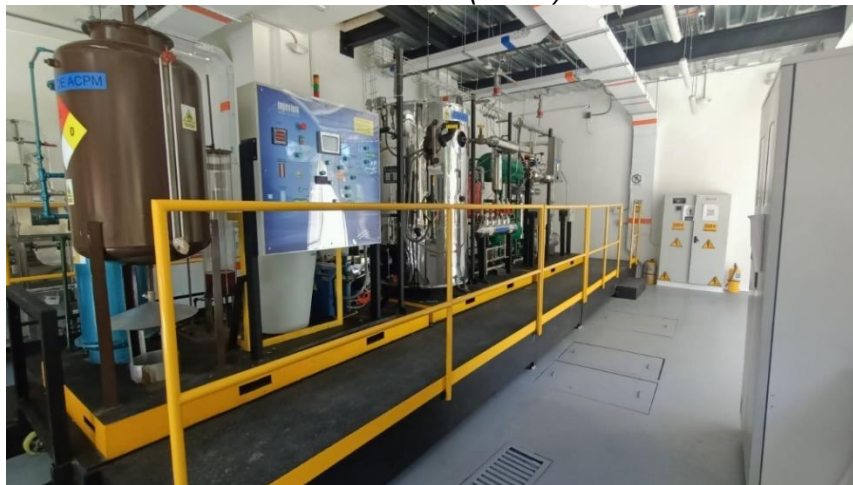
Figura 2. Centro de Servicios Industriales (CESI)
