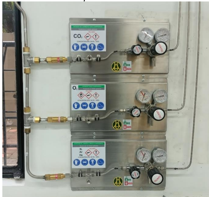
Figura 9. Punto de Gases Especiales BIOCAL
