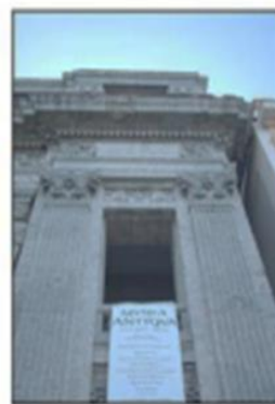
Detalle exterior_ Columnas
