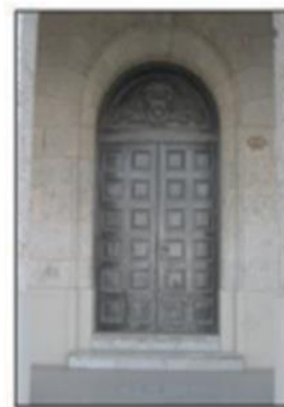
Detalle exterior_ Puerta de acceso
