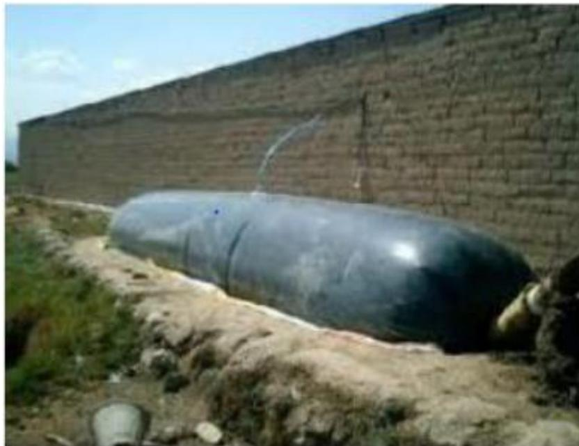
**Nota.** Esta imagen muestra el esquema de biodigestor estructura flexible. Tomado de: Rodríguez Ramon (2012) Implementación y Construcción de un Biodigestor Hindú de Estructura Flexible con el Aprovechamiento de las Excretas de Ganado Vacuno, Aplicado a la Quinta Experimental Punzara. Loja, Ecuador. <https://dspace.unl.edu.ec/jspui/bitstream/123456789/12371/1/Rodr%c3%adguez%20Ram%c3%b3n%2c%20Luis%20Guillermo.pdf>
