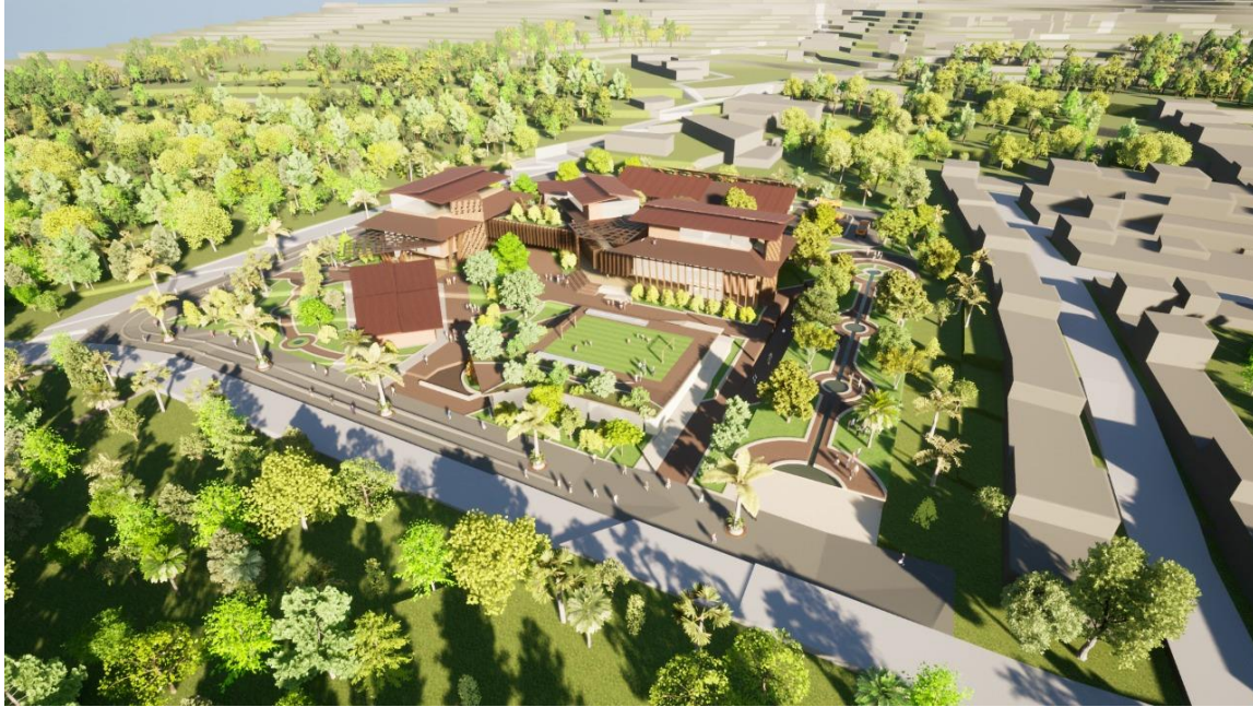
Figura 56. Vista aérea oriental del proyecto.
