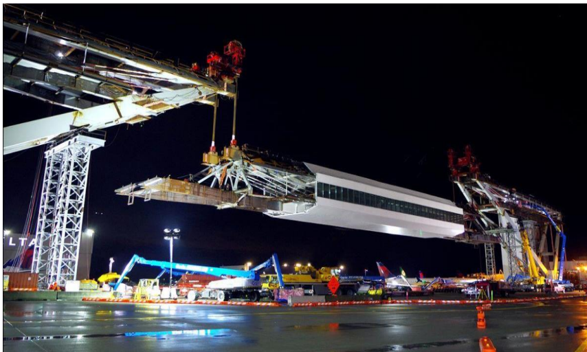
Figura 51. Izaje de puente aeroportuario de 1500 Ton
