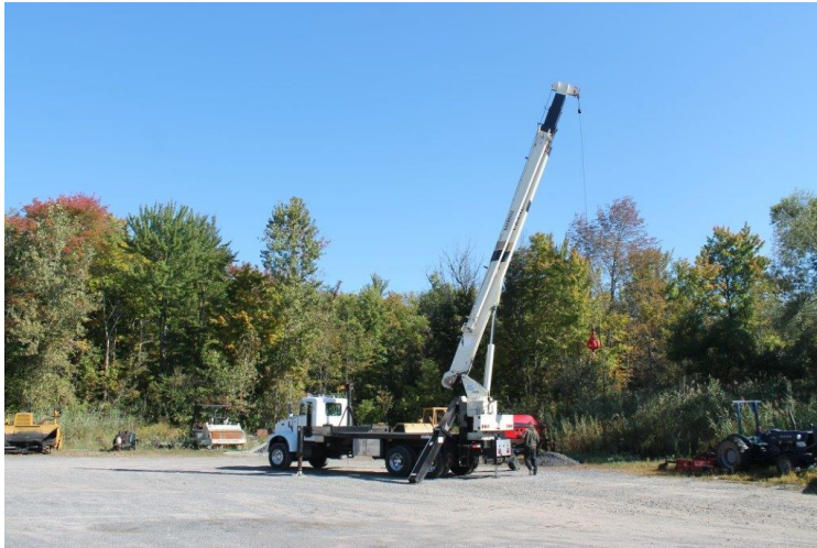
Figura 17. Camión grúa de 20 Toneladas
