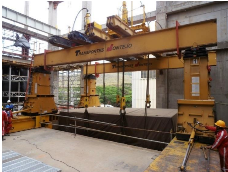
Figura 45. Izaje de generador de 200 Ton, Termotasajero
