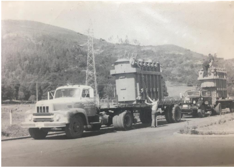
Figura 16. Transporte de transformador
