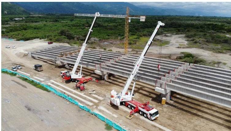
Figura 18. 2 Grúas telescópicas de 300 toneladas
