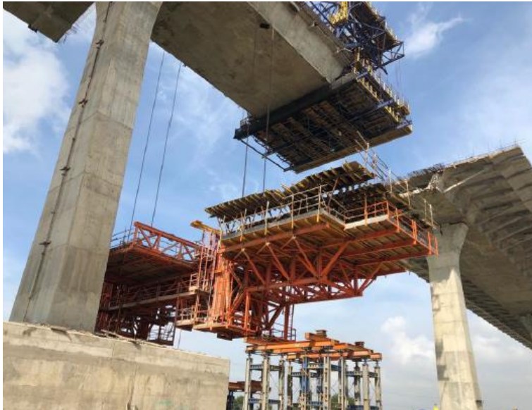
Figura 28. Izaje de secciones.
