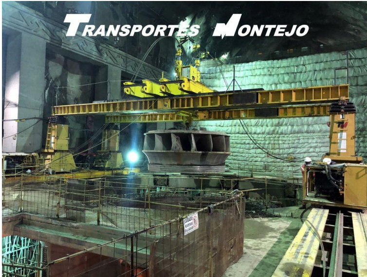
Figura 48. Izaje de turbina, Hidroituango
