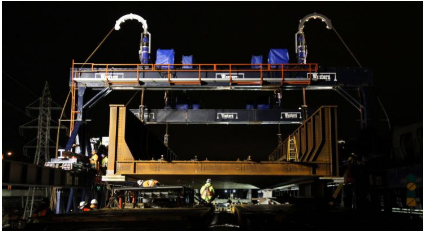
Figura 50. Reemplazo de puente ferroviario, Canadá
