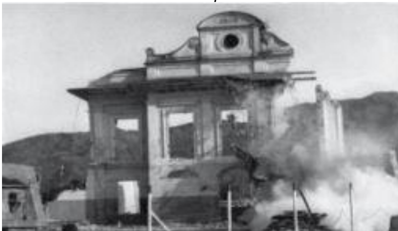
Figura 1. Demolición de la Estación Ospina
