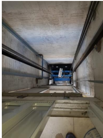
Nota. Fotografía del pozo de Ascensor WS-930
