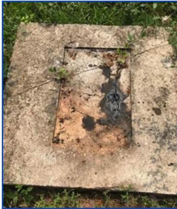
**Nota:** Presencia de hidrocarburos en la placa de abandono por posibles filtraciones en el pozo tomado de: ECOPETROL, *Formato para la* Justicación de Intervención de Pozo Casabe-418, Bogotá D.C.
