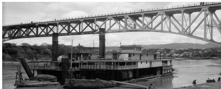
Imagen 2. Puente férreo de Girardot
