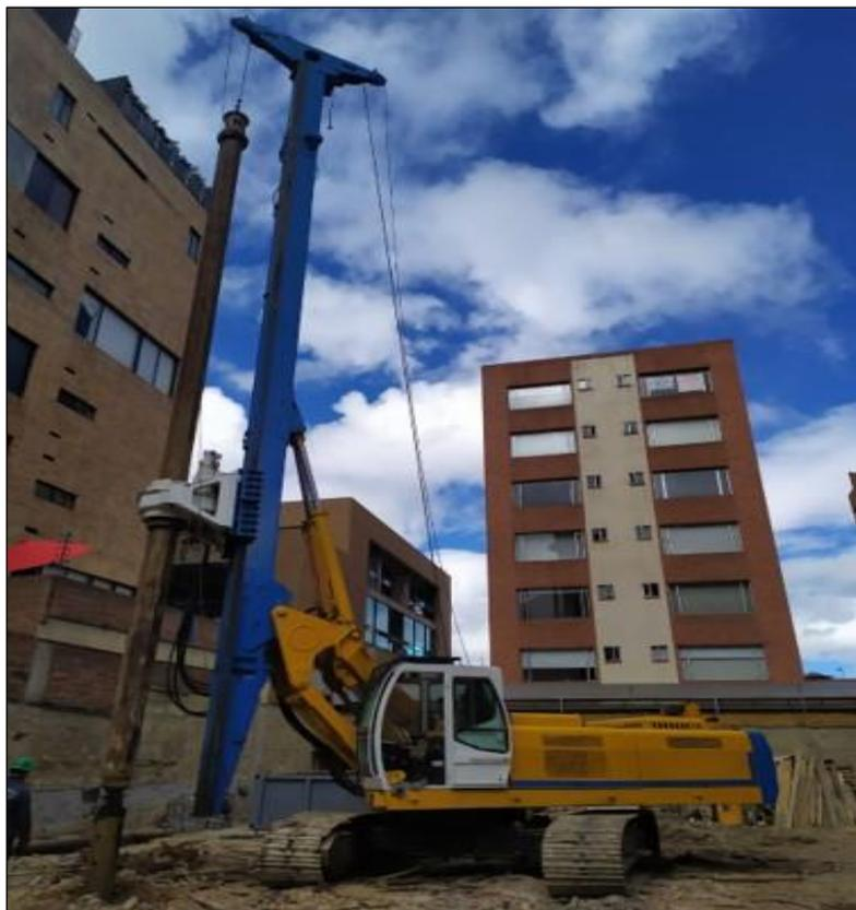
**Nota.** esta muestra la piloteadora para la cual se elabora el plan de mantenimiento.
