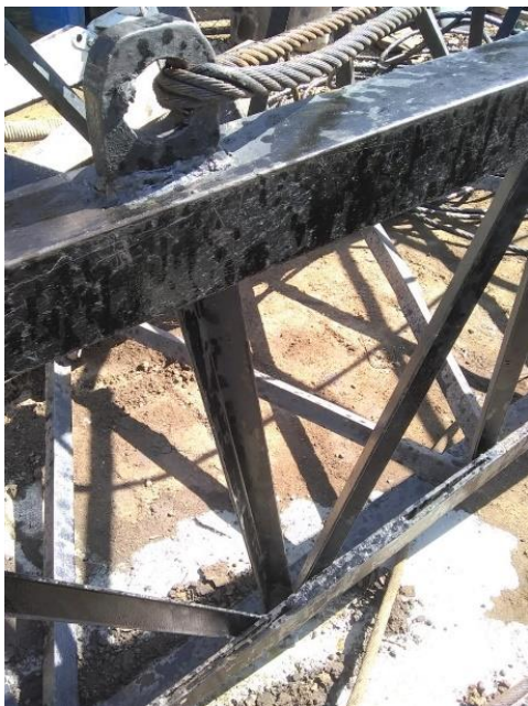
Imagen 12. Estructura reticular celosía
