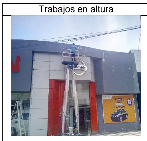
Figura 5. Trabajo en alturas
