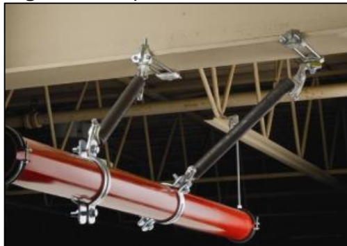
Figura 26. Soportes sismo-resistentes.
