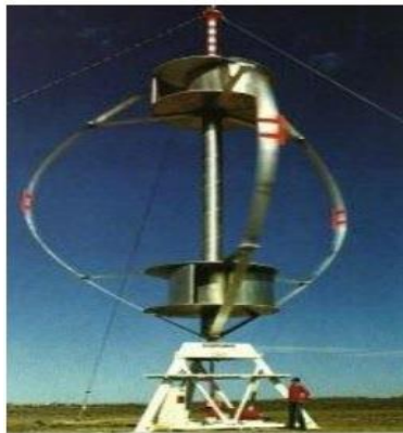
Figura 4 Aerogenerador de eje vertical tipo Darrieus
