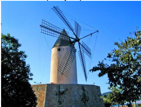
Figura 2 Molino de Santa Ponça en Calvià, restaurado en 1995 añadiendo un nuevo capitel y aspas.
