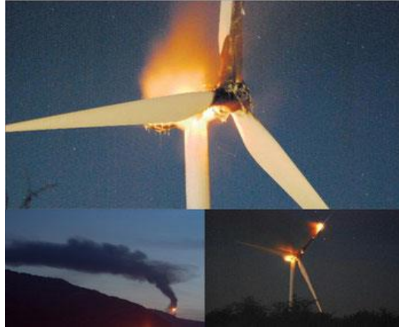
Figura 21 Incendio de una turbina tripala
