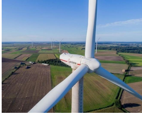
Figura 24 Aerogenerador de eje horizontal tripala de ACCIONA, España.
