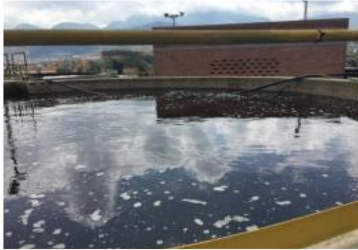
Figura 16. Zanjón Oxidación Oriental y Occidental
