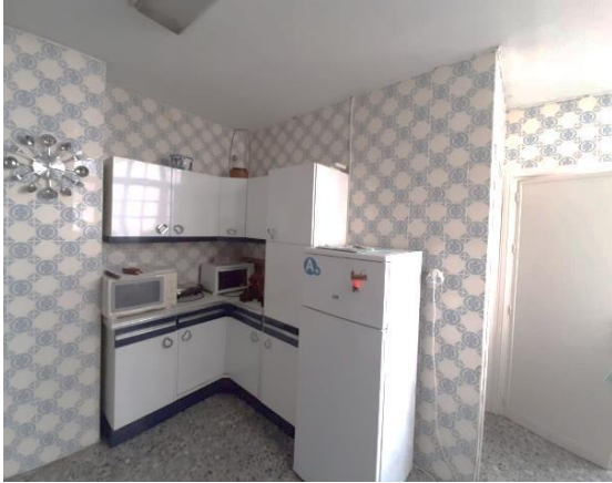
Imagen 94. Estado actual de la cocina
