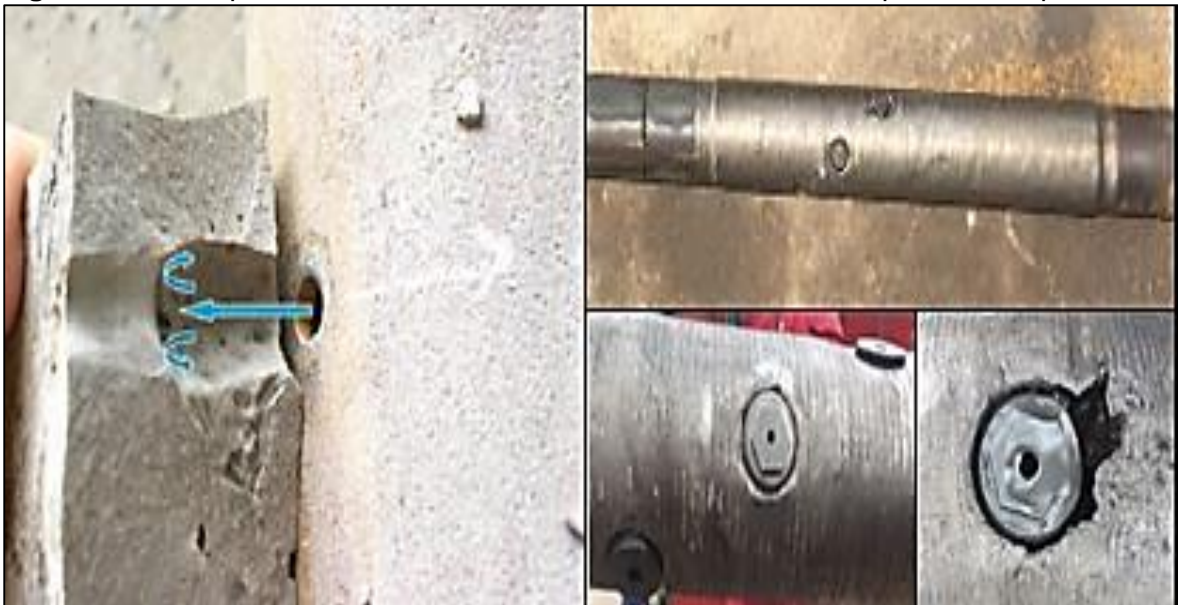
Figura 13. Túnel perforado mediante cañoneo abrasivo con sus respectivas boquillas.
