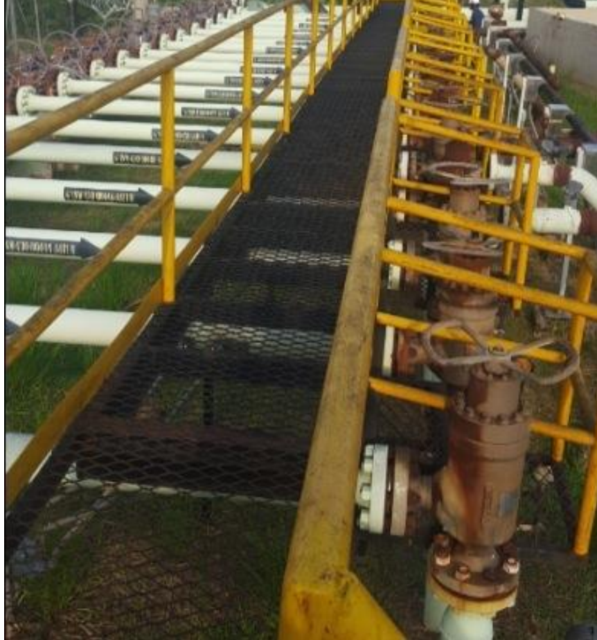
Figura 9. Manifold de descarga brazos A y B, con su juego de choques.
