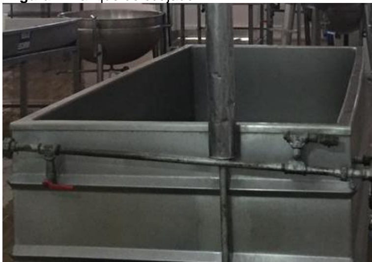
Figura 7. Tanque de cuajado 1
