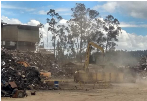
Figura 6. Imán para separación mecánica de chatarra planta Tuta GERDAU DIACO S.A
