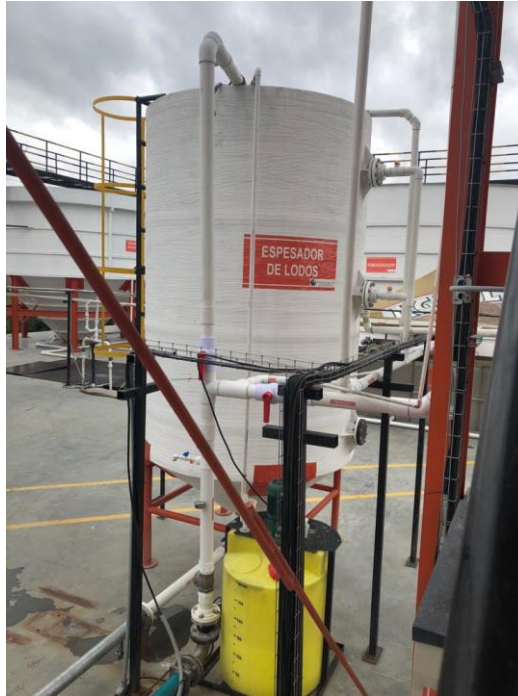
Figura 16. Equipo espesador de lodos.
