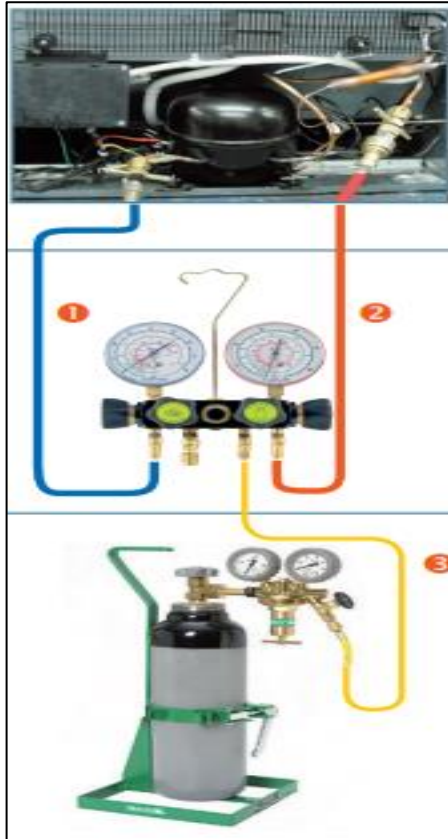
Figura 65. Prueba de fugas a presión
