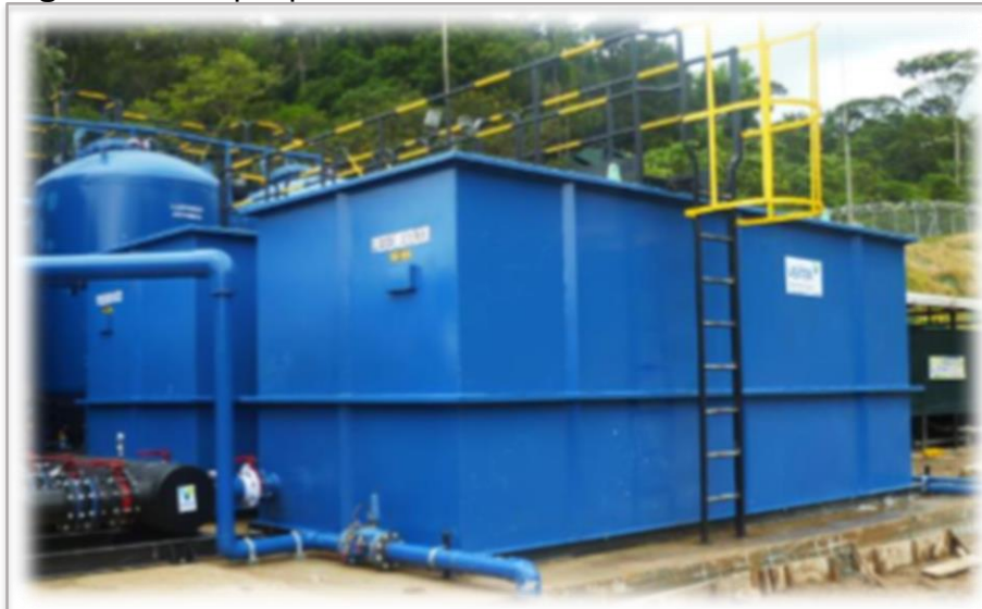
Figura 8. Tanque pre-sedimentador.
