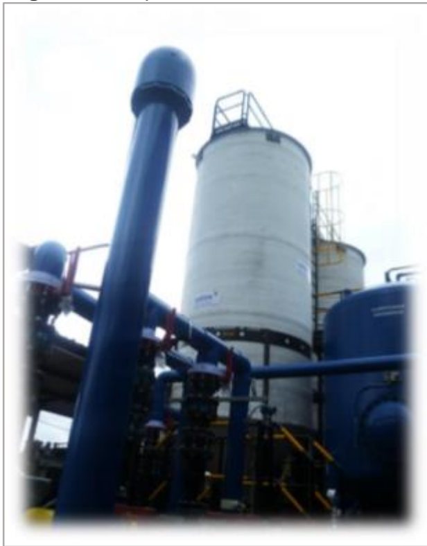
Figura 11. Espesador de lodos.
