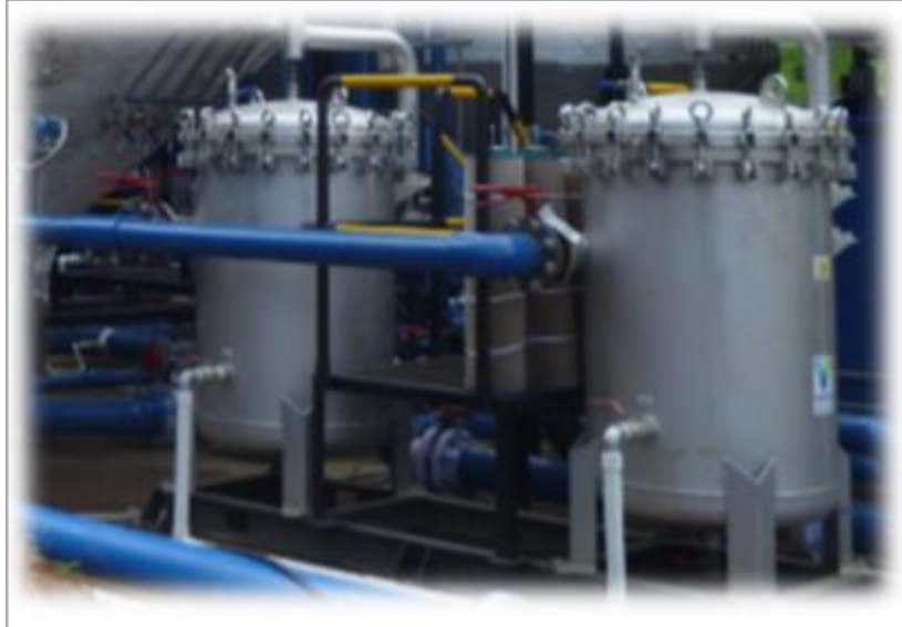
Figura 10. Microfiltrador.
