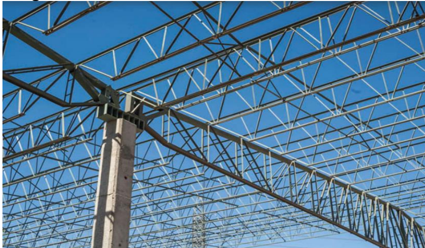
Imagen 62. Referente estructura en acero
