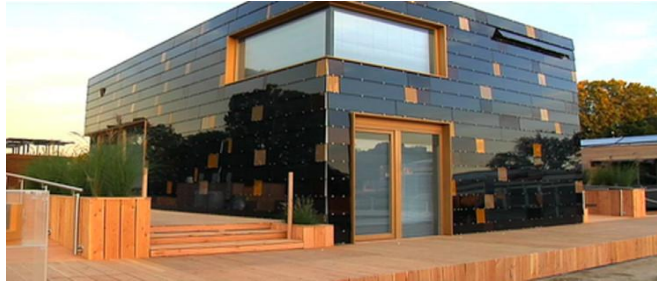
Figura 15. Instalación solar sobre fachada
