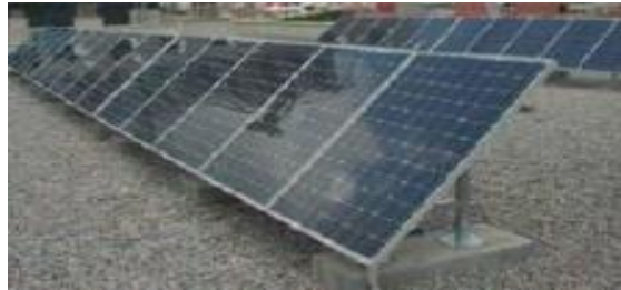
Figura 16. Instalación sobre techados y cubiertas
