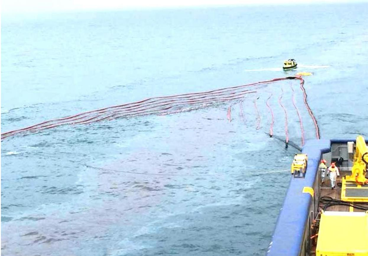
**Nota.** Sistema de barreras en configuración hidrodinámica para la recogida de vertidos de petróleo en el mar. Tomado de: “Técnicas de recuperación y limpieza de derrames de petróleo en el mar: equipos profesionales” [En línea]. Disponible: <https://markleen.com/es/respuestas-derrames/limpieza-derrames-petroleo-mar/> [Accedido: oct.09.2023]
