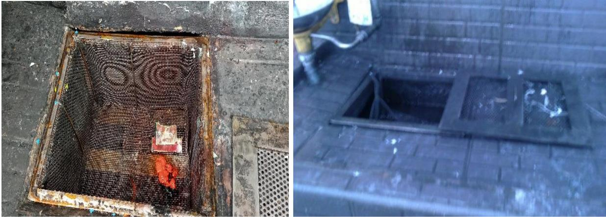
Una vez se vierte el agua de la poseta, esta llega mediante la tubería a las cajas de recepción, ubicadas en el piso a la entrada de la PTAR, como se ve en la figura 21; se acciona manualmente el tablero eléctrico el botón “bomba tolva 1” para llevar el agua a la tolva 1 o 2 según lo requiera el proceso.
