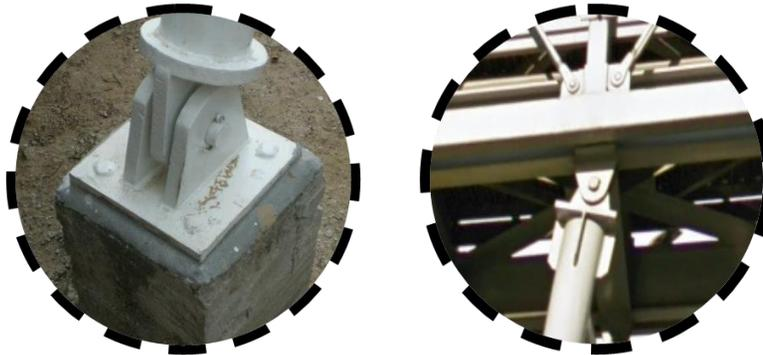
**Nota.** Ejemplos reales de los anclajes de la estructura al suelo y a la plataforma.
