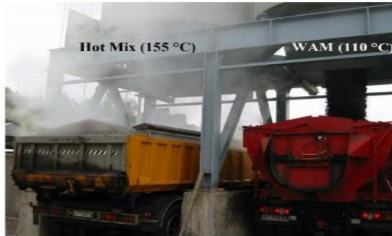
Figura 8. Relación de humos entre una mezcla convencional y otra semicaliente
