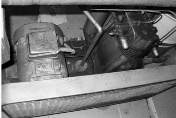
Imagen 3. Compresor abierto acoplado por correas
