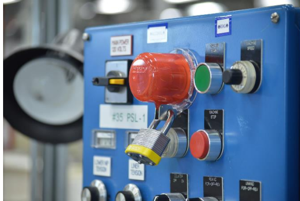
Imagen 162. Evitar arranque de la maquina
