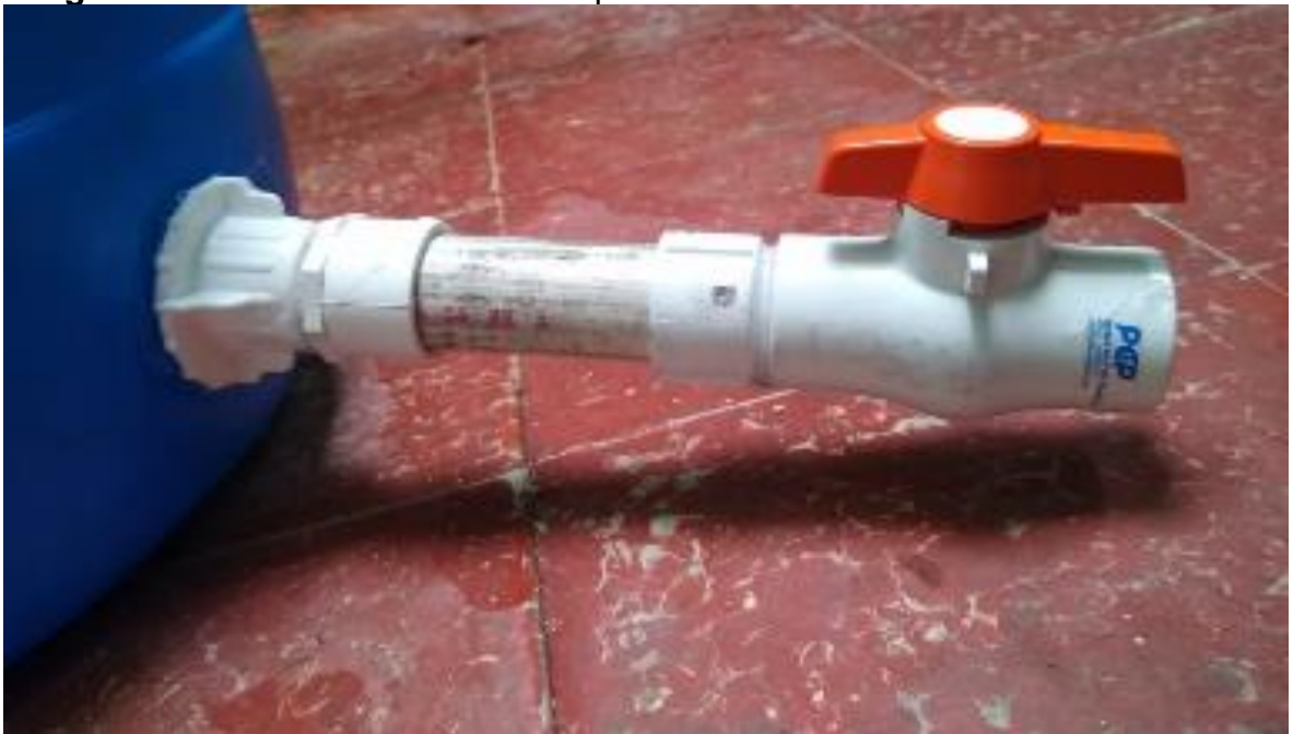
Imagen 13. Tubo salida efluente más pesado terminado
