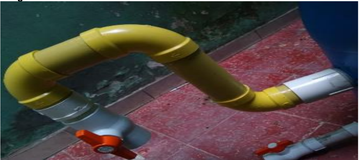
Imagen 11. Tubo salida biol terminado
