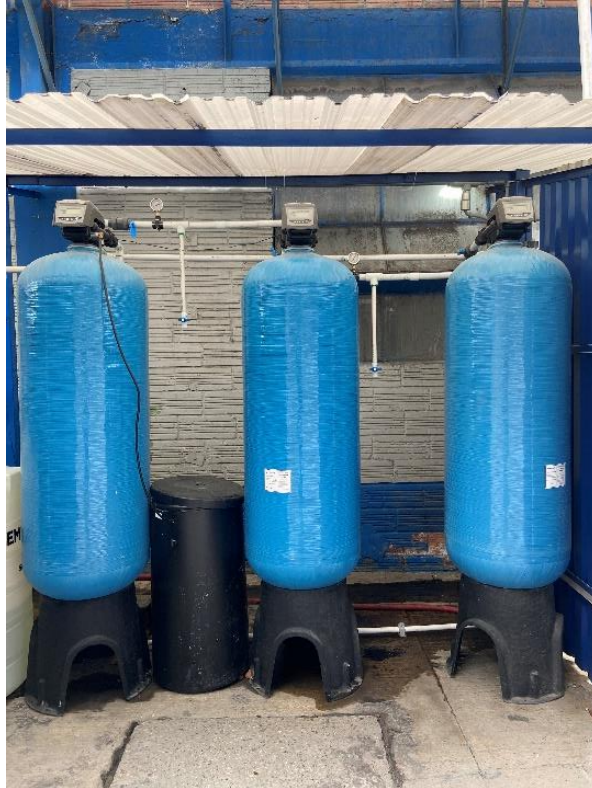
Imagen No.4.Tren de suavización planta O-I PELDAR Zipaquirá
