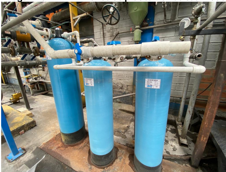
Imagen No.22. Banco de prueba tren de suavizado.
