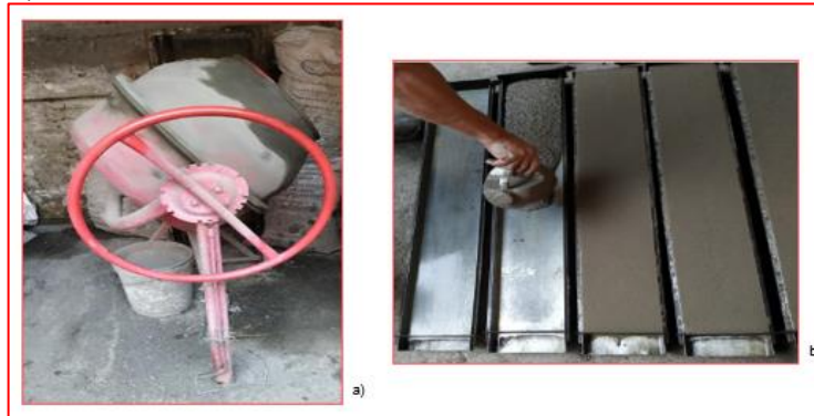
Figura 135. Proceso de fundido, a) mezcla de los materiales, b) vertimiento de la mezcla en las formaletas
