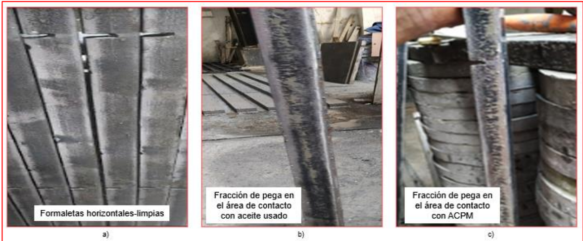
Figura 21. Formaletas metálicas horizontales, a) limpias, con fracción de pega por la aplicación de b) aceite usado.
