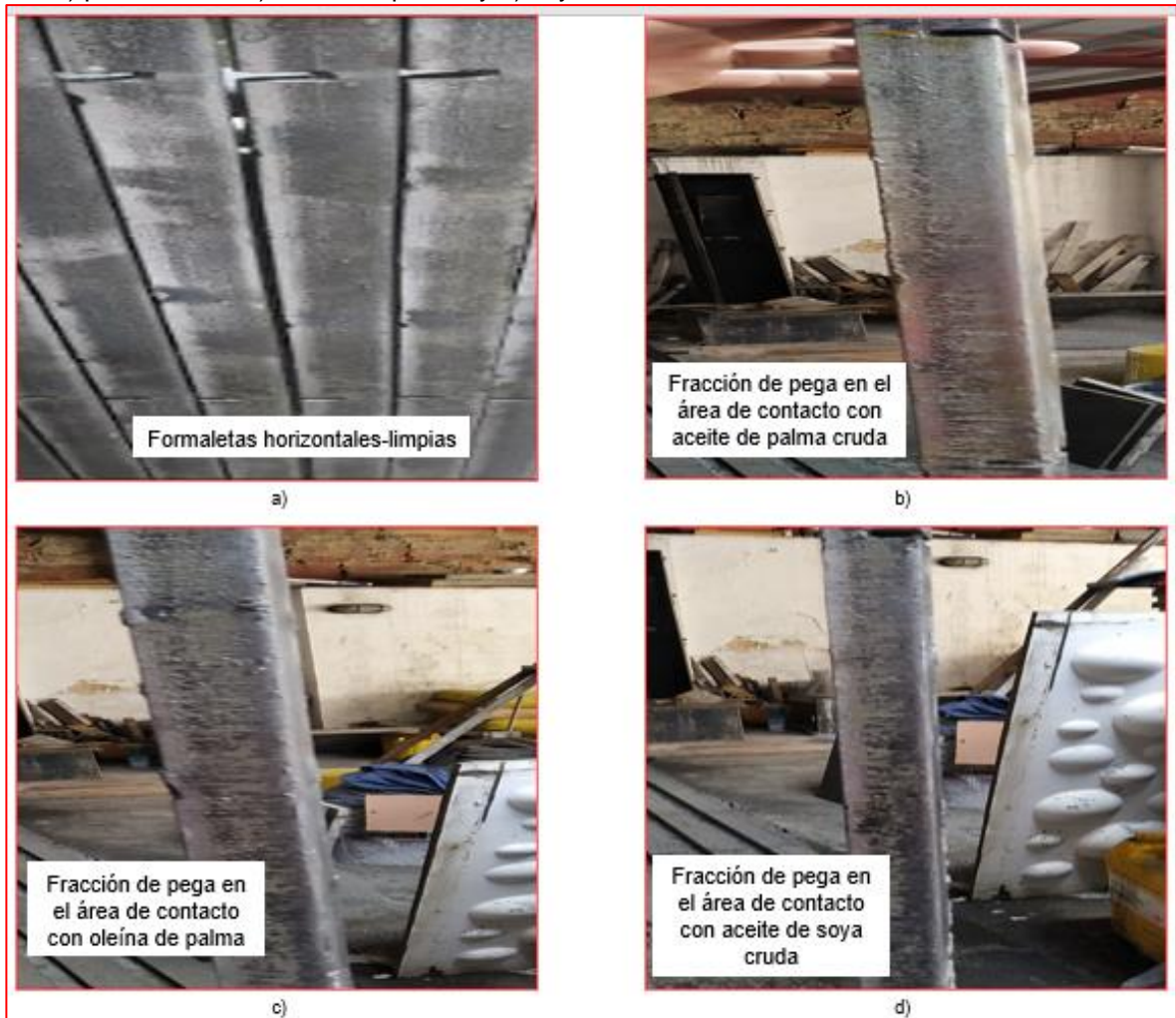
Figura 20. Formaletas metálicas horizontales a) limpias, con fracción de pega en el área de contacto con b) palma cruda, c) oleína de palma, y d) soya cruda.
