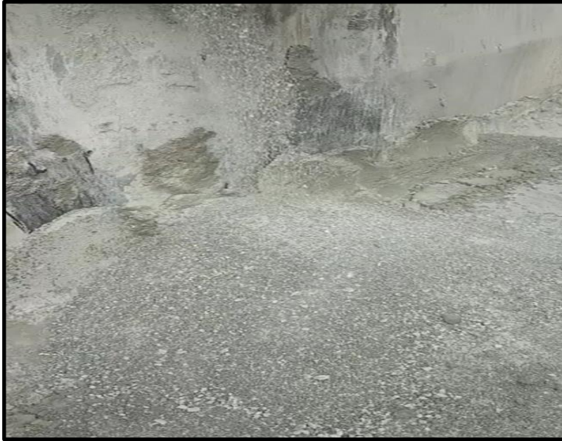
Figura 15. Cortes tratados por el equipo Q-Drying-Kiln.
