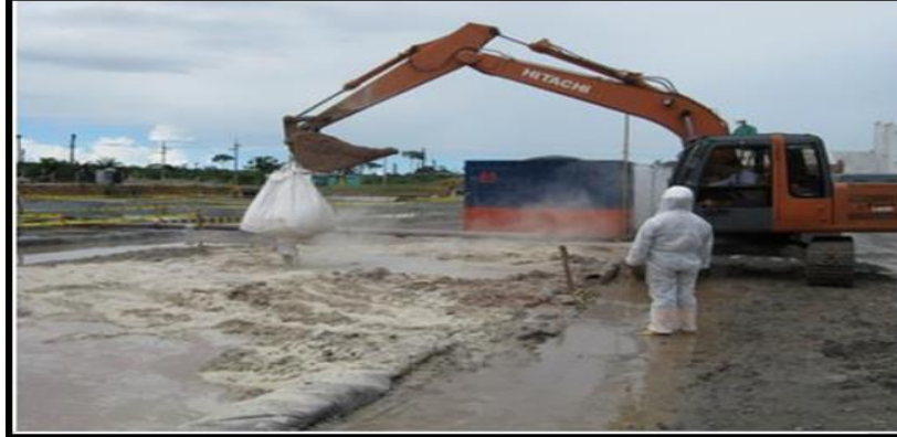
Figura 5. Estabilización con Cal viva.
