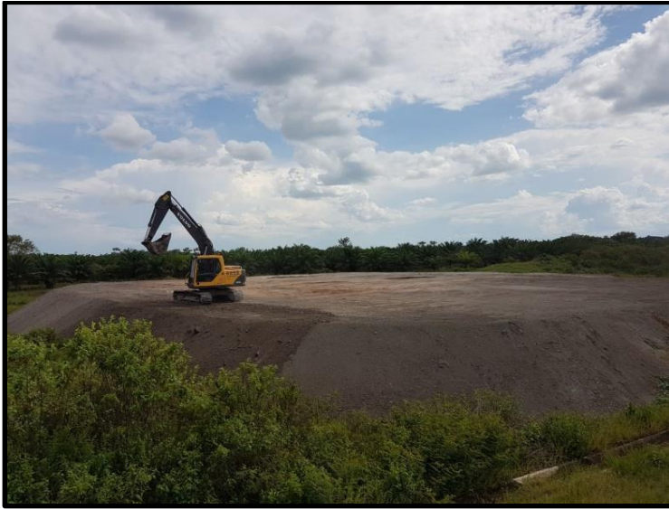
Figura 17. Disposición en Zodme con retroexcavadora.
