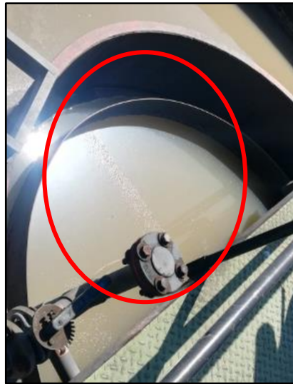
Figura 14. Tanque de decantación.
