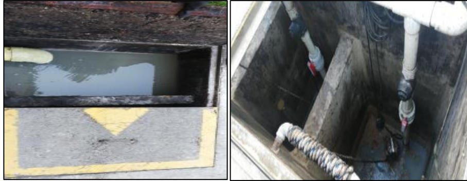
Figura 6. Trampas de grasa laboratorios de calidad.
