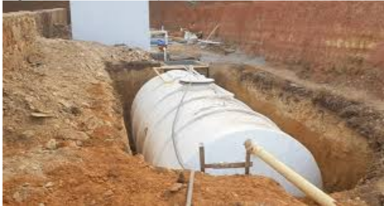
Figura 5. Sistema de tanque modular enterrado.
