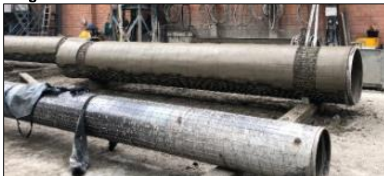
Imagen 11. Proceso de revestimiento externo.
