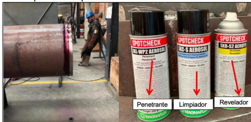
Imagen 6. Pruebas de verificación de soldaduras con sus respectivos líquidos.
