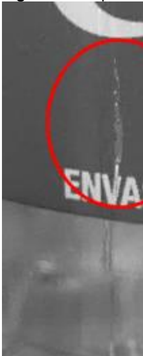
Figura 18. Inspección visual muestra 2 ciclo 15
