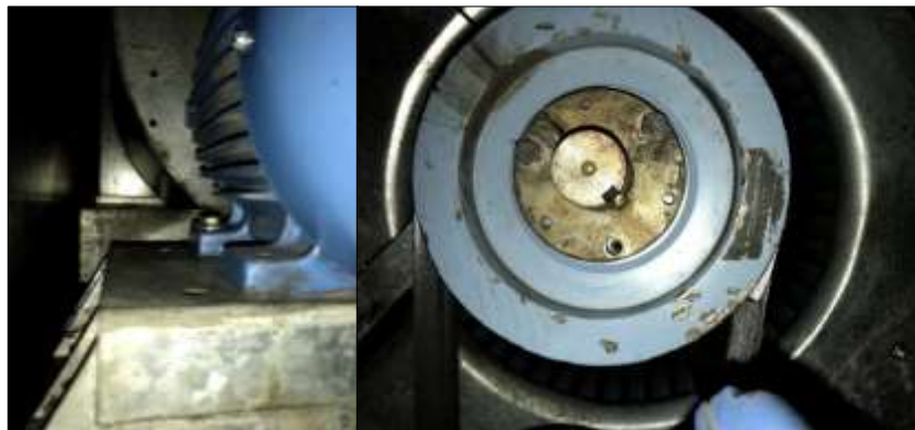
Figura 32. Motor y polea conducida y transmisión ventilador
