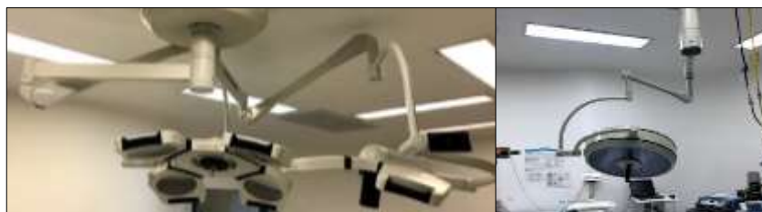
Figura 25. Lámparas cielíticas de las salas de cirugía
