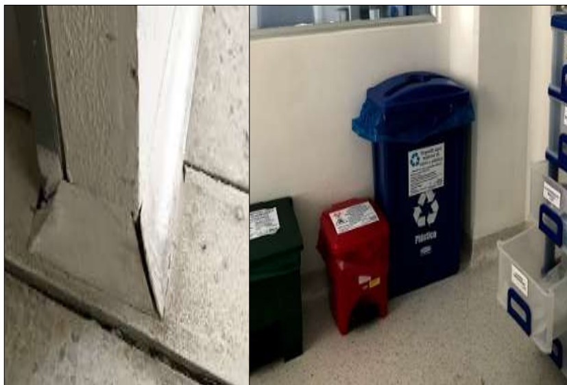
Figura 43. Guardaescoba media caña y depósito de residuos
