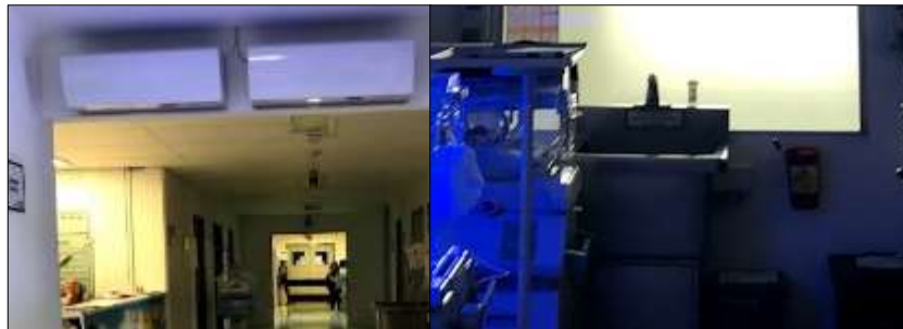
Figura 54. Lavado de manos y avisos de restricción
