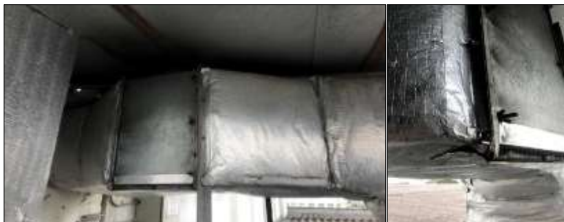
Figura 67. Filtros HEPA y compuertas de inspección
