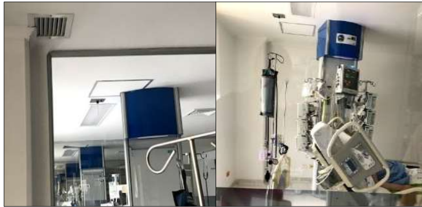
Figura 40. Rejilla extracción y unidad de control signos de vitales
