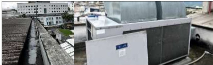
Figura 78. Unidad condensadora de imagenología
