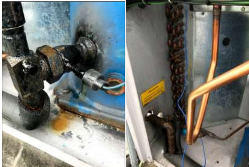
Figura 28. Válvulas de servicio y serpentín condensador
