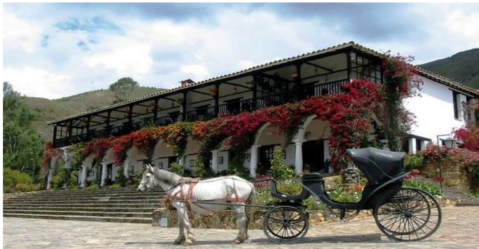
Figura 8. Hospedería y Centro de Convenciones Duruelo
