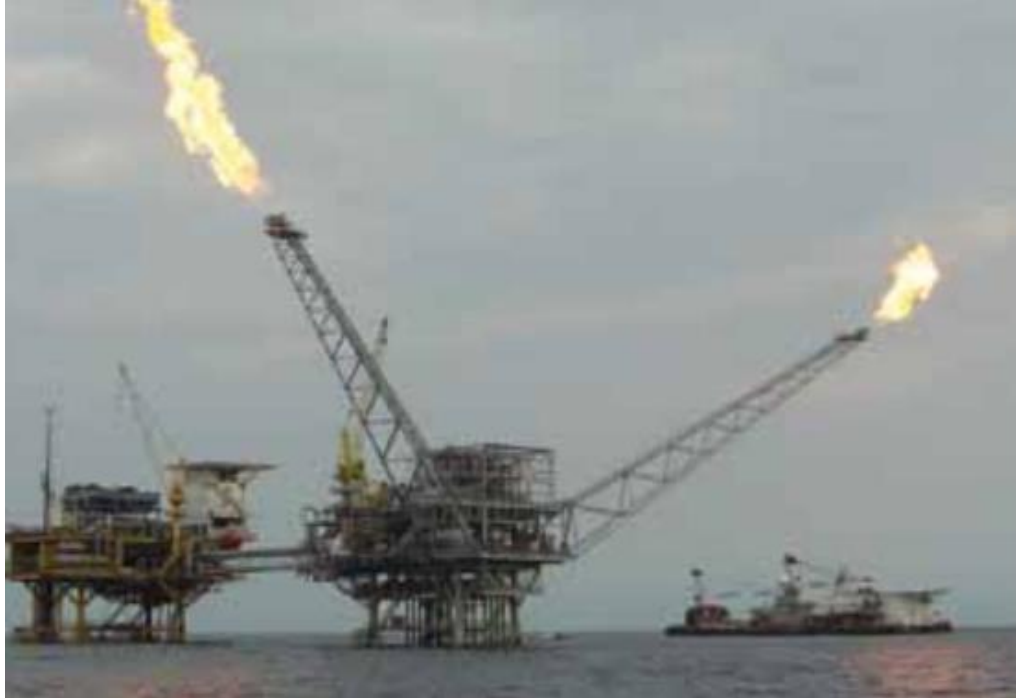
Figura 19: Sistema de quema de puntos múltiples elevados.
