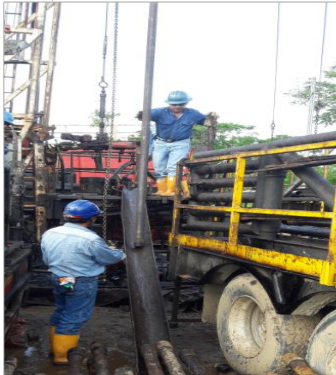
Imagen 5. Canal de deslizamiento de tubería utilizada en campo.
