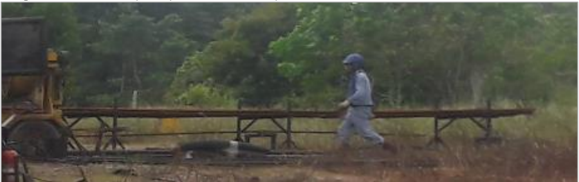
Imagen 7. Racks de soporte para sarta de completamiento.
